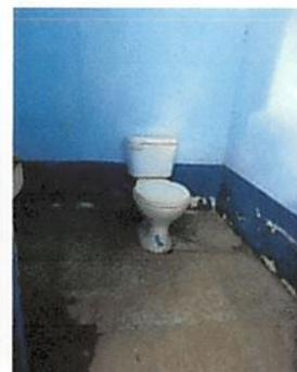
Foto 2: Cambio de 2 baños sanitarios con sus respectivos accesorios e instalación de azulejos.
