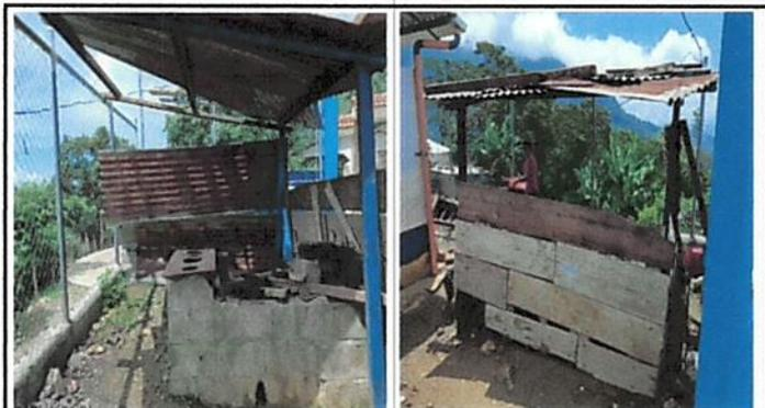
Sustitución de estufa rural, incluyendo, polleton y chimenea, sustitución de techo de madera por estructura metálica, cerramiento de alrededor de cocina a 1 metro de alto
