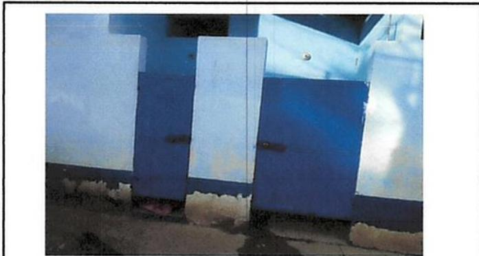
Foto1: Reparación de 2 puertas de baños (Limpieza, Soporte y pintura)
